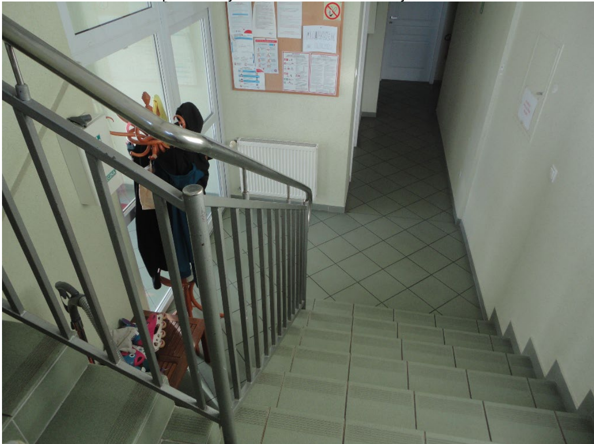
Nr 6 – Klatka schodowa parter – wydzielenie klatki schodowej drzwiami w klasie EI30
