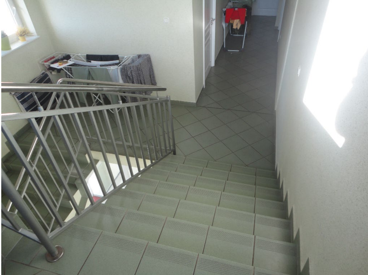
Nr 5 – Klatka schodowa I piętro – wydzielenie klatki schodowej drzwiami w klasie EI30
