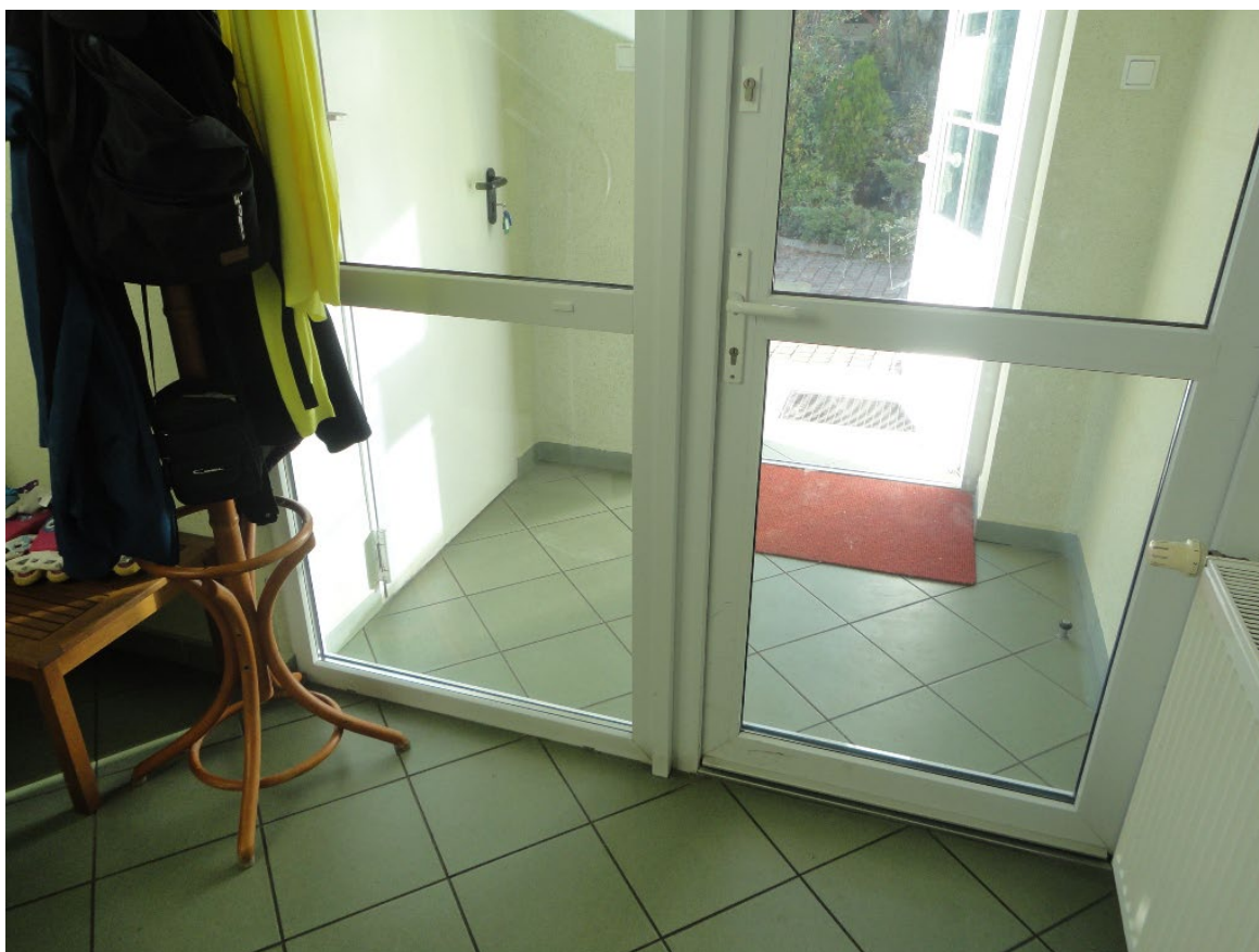
Nr 4 – Wymiana drzwi na klatce schodowej poddasza na EI30 (90+30cm) z samozamykaczem
