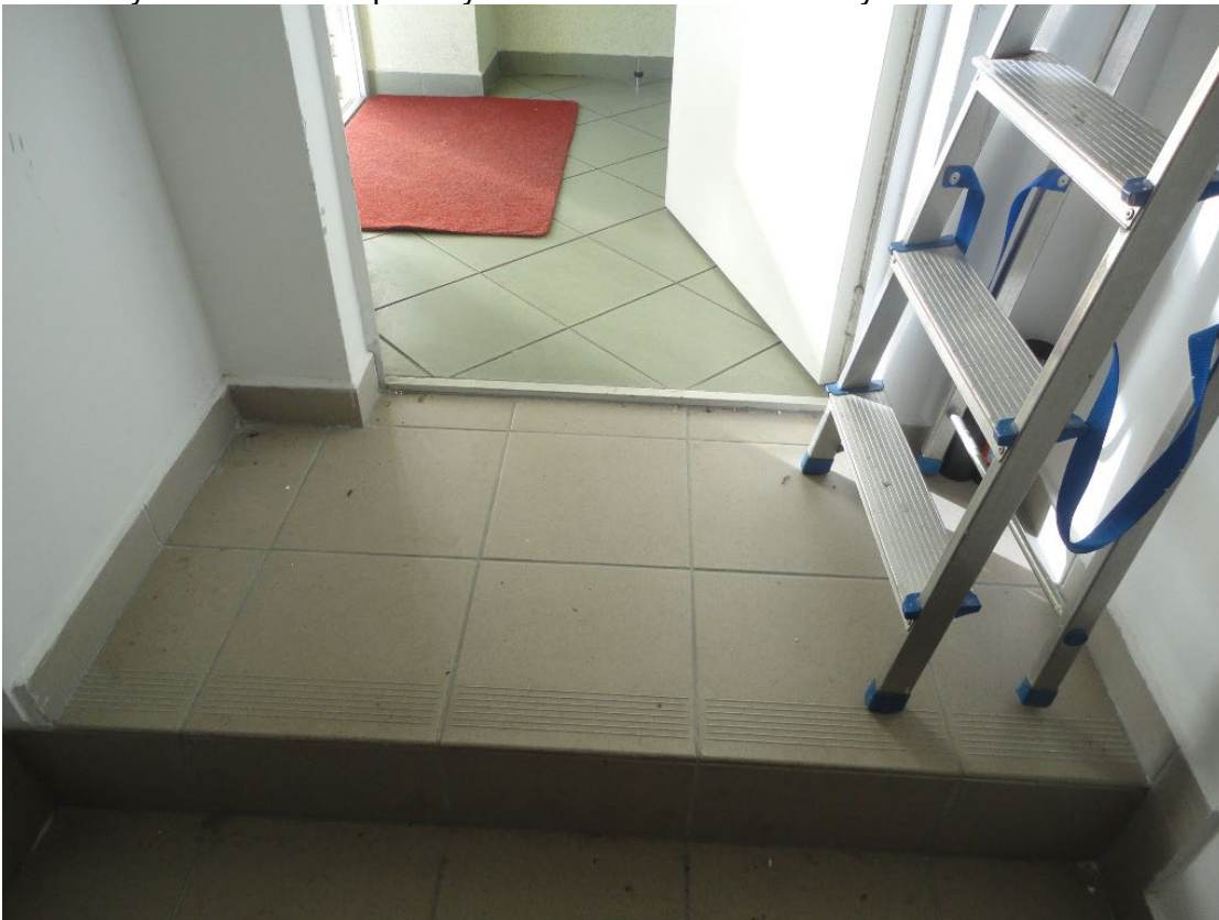
Nr 3 – Parter hol – wymiana ścianki aluminiowej z drzwiami (drzwi szer. 90cm) z samozamykaczem
