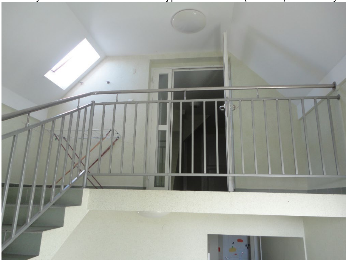
Nr 4 – Wymiana drzwi na klatce schodowej poddasza na EI30 (90+30cm) z samozamykaczem
